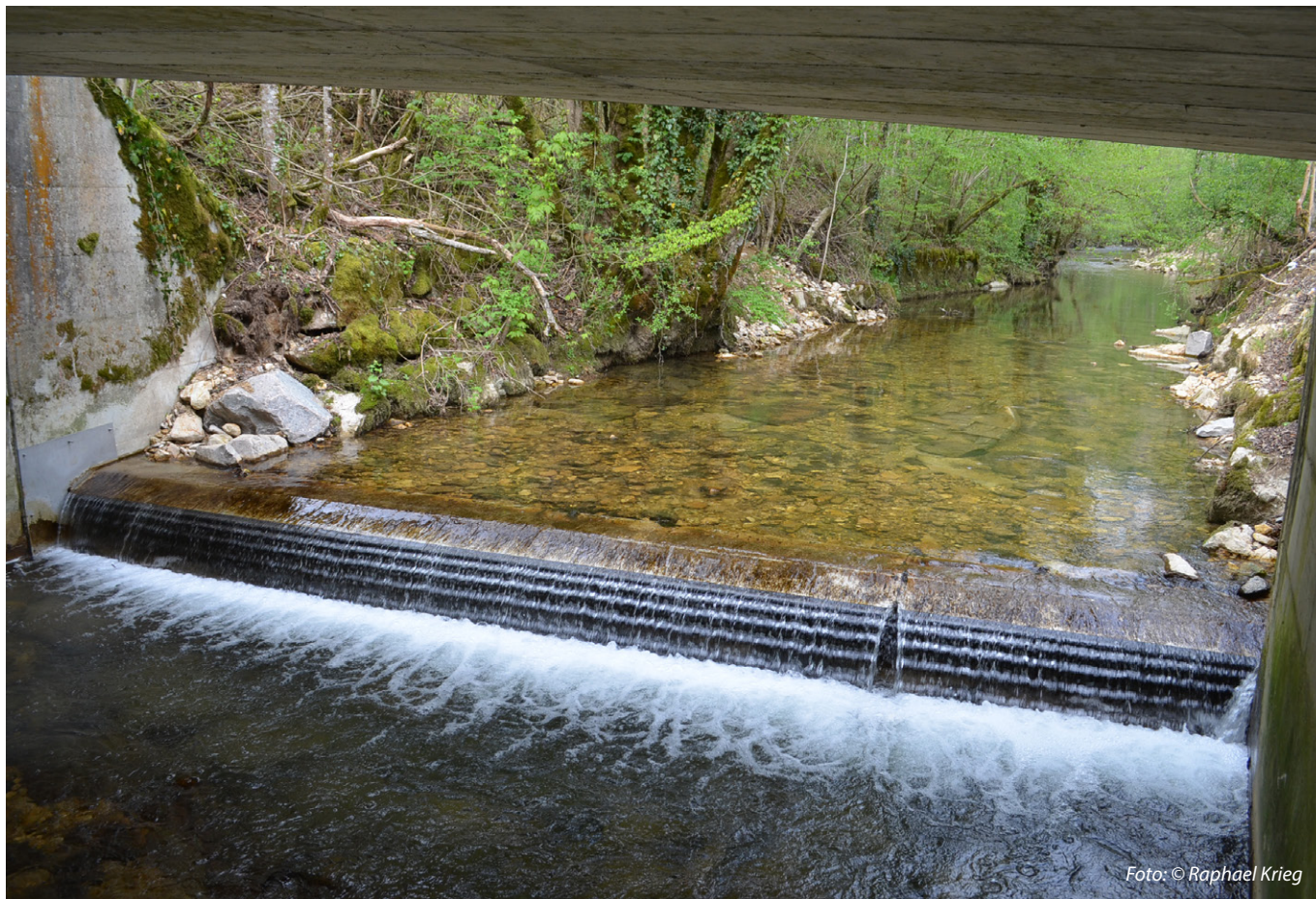
Abb. 2: Krebssperre in der Lützel im Kanton Baselland: Die Brückenpfeiler dienen als seitliche Rückführung bzw. Landgangssperre.
