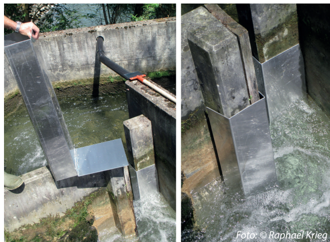
Abb. 1: Beispiel einer Krebssperre für einen Becken-Schlitz-Pass aus Münchenstein (BL). Nach neuem Kenntnisstand müssen zusätzlich weitere Bleche an den Wänden des Beckens und der 90° Winkel abgerundet werden.
